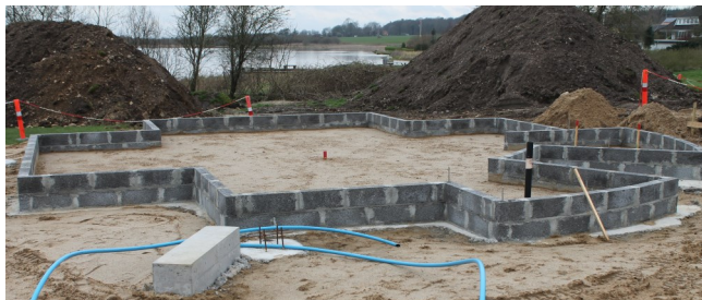
Fundamentet til Søvavillonen er nu støbt. Sådan så det ud den 31. marts. (Foto: nc)
